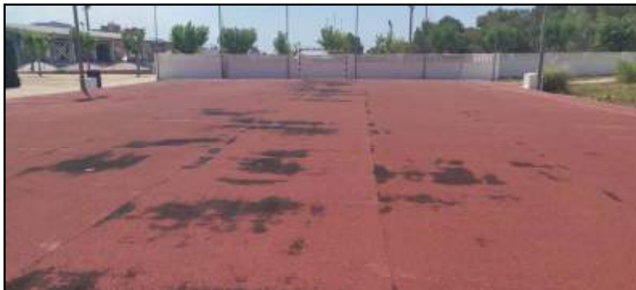
Fotografía 1: Vista general de la pista
